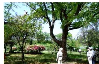
(高所作業車による剪定作業)
