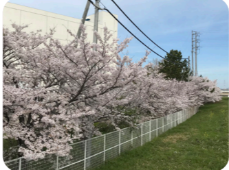
33 高田中継ポンプ場 高田町21
